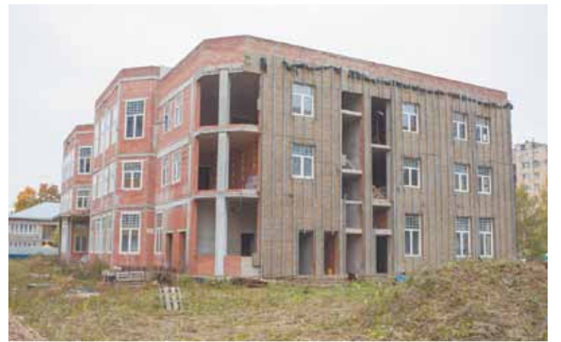
Детский сад на 185 мест с бассейном в поселке Металлострой
